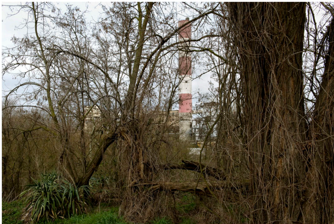
La chaufferie Série Fractal Spaces , 2016
